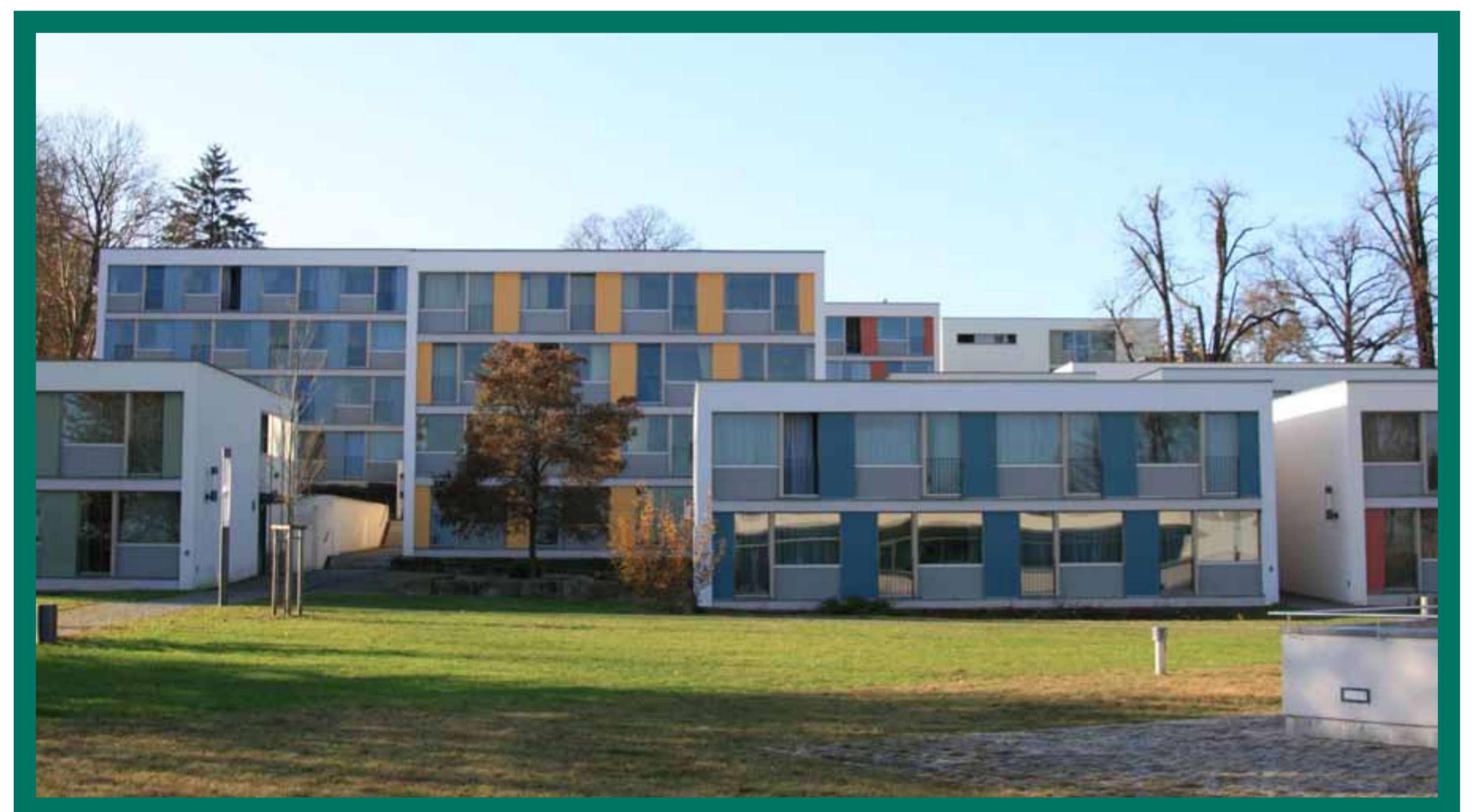
Das Mittelstufendorf des Internats: gute Bedingungen für Solaranlagen.
