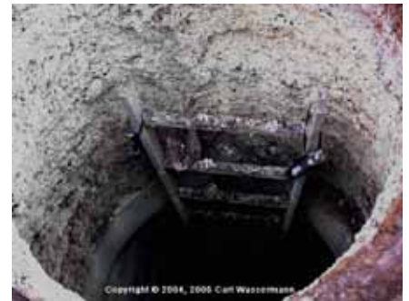
> Korrosionsschäden
